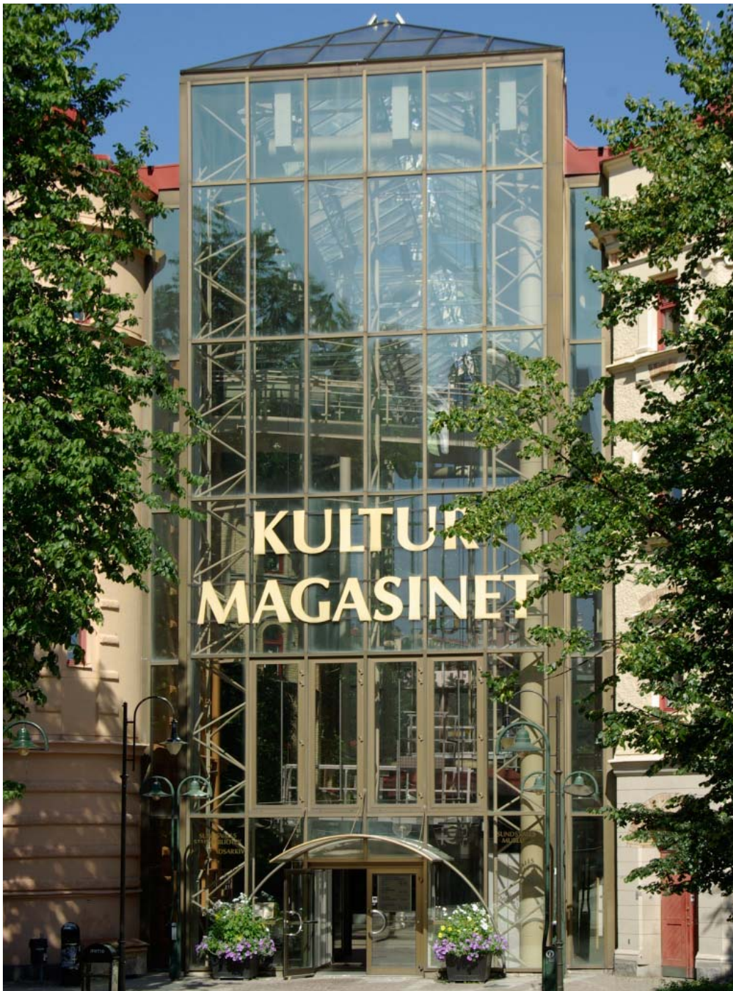
Kulturmagasinet's entré från Sjögatan.
