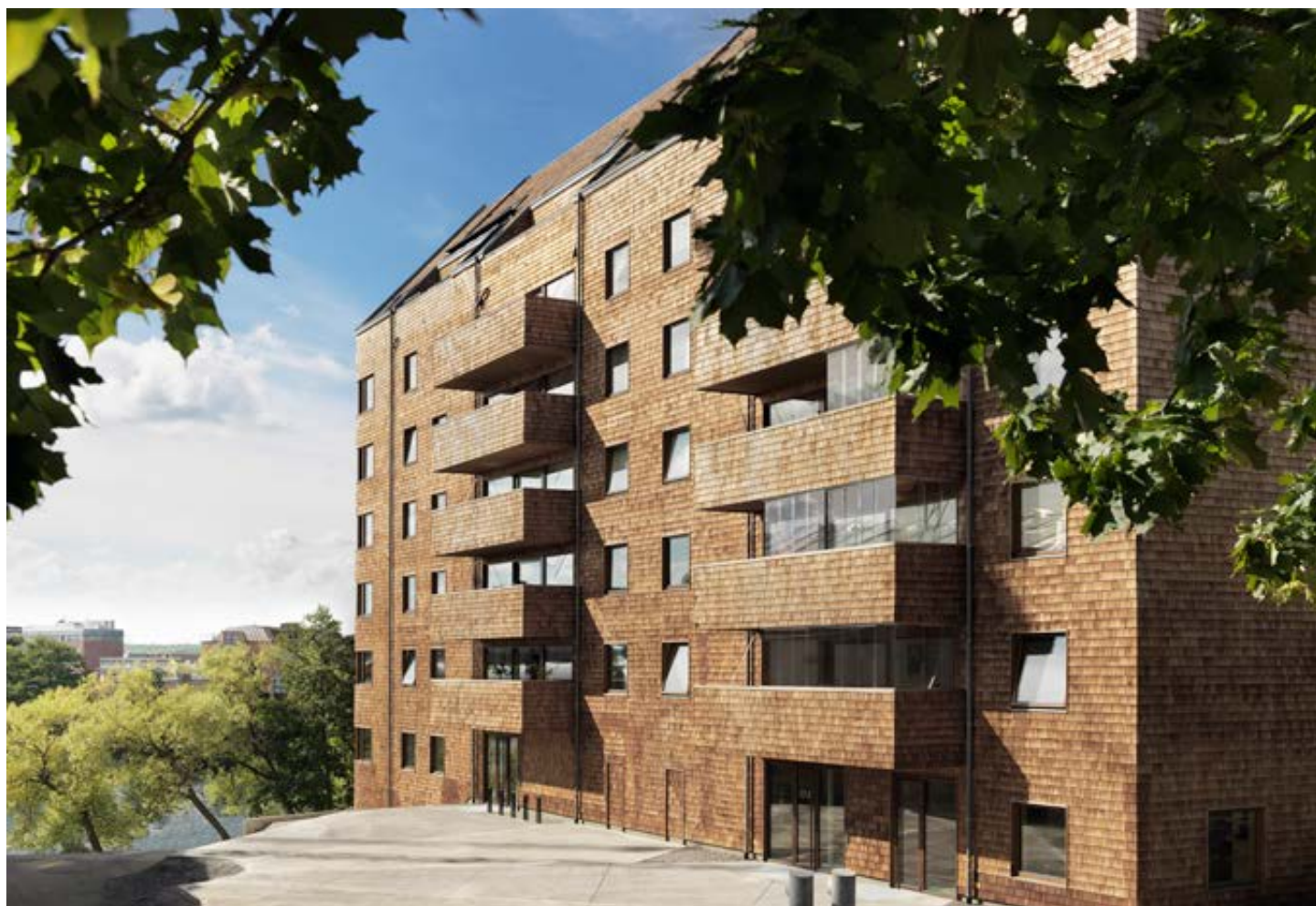
Flerbostadshuset Strandparken i Sundbyberg. Arkitektkontor: Wingårdhs. Beställare: Arvet
