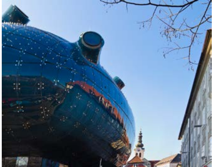
I Konsthall i Graz i Österrike. Organiskt formade blå paneler av polymetylmetakrylat. Foto: Orietta Gaspari
