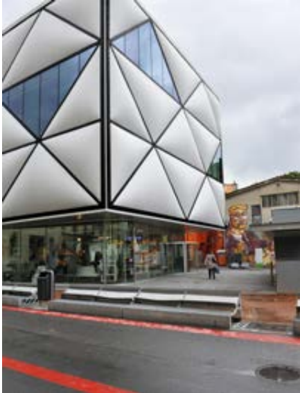
La Miroiterie, Lausanne, Schweiz. Glasrutor klädda med luftfyllda ”kuddar” av PTFE (polytetrafluoroethylene) och ETFE (ethylene tetrafluoroethylene). Arkitekter: Ueli Brauen och Doris Wälchli Foto: Christian Goupi Alamy
