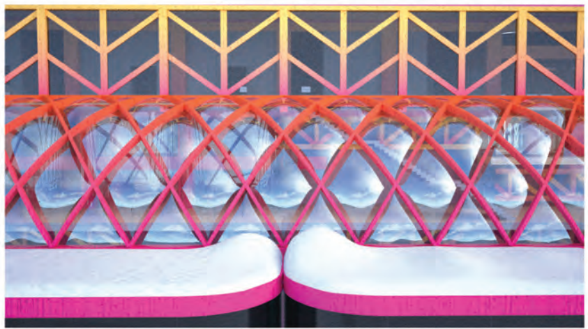
Foajé fasad mot väst. ETFE film används här för att göra strukturen lättare och öka isolerings kapacitet
