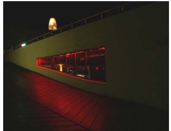
parkeringsdäcket Hill, uppfartsrampen
