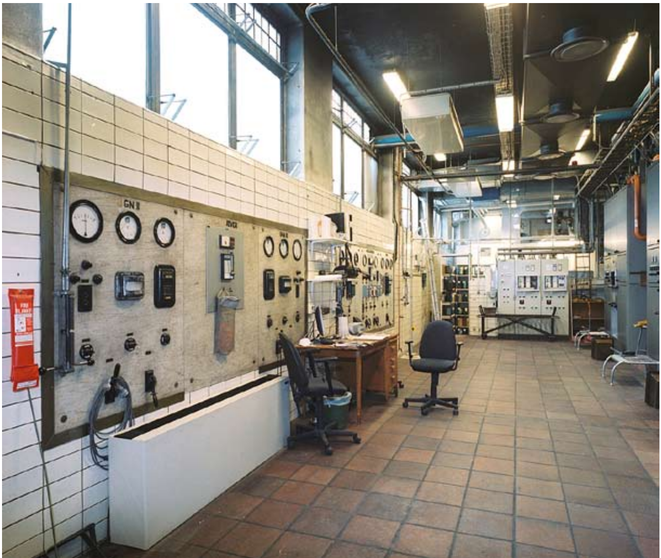
Ugnsrummet med bevarade instrumentpaneler från den ursprungliga elektriska krematoriedriften. The furnace room with its surviving instrument panels – part of the crematorium's original electrics.
