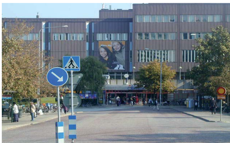
Bussgatan samt den norra entrén.
