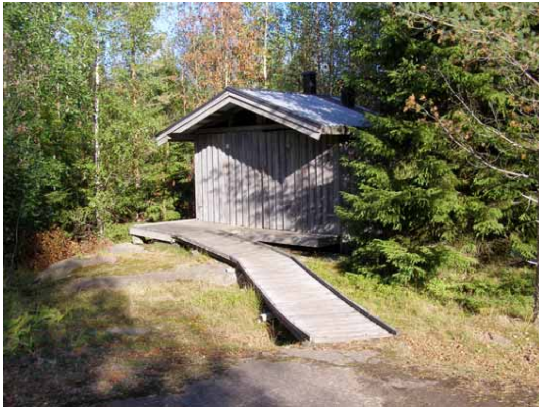
Torrtoalett med tre sektioner. En sektion är handikappanpassad. Placerad i nära anslutning till entréplatsen.
